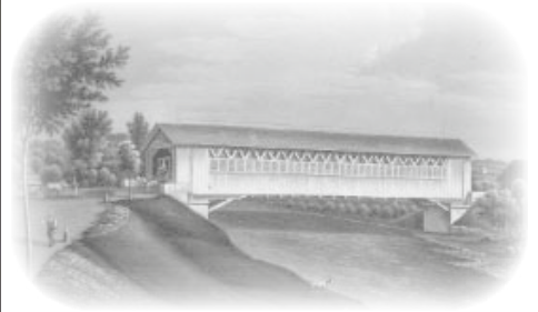
Die neue Brücke in Adlischweil
