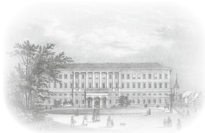
Das Postgebäude in Leipzig
