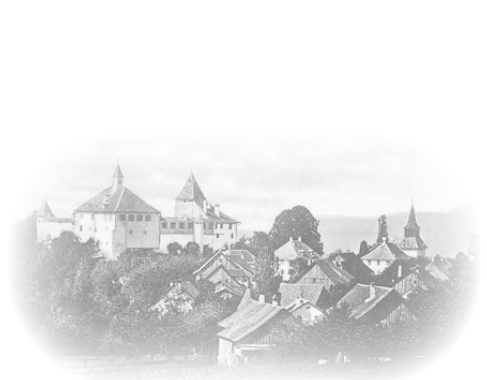
Ansicht von Kyburg
