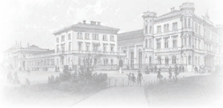
Der Westbahnhof in Wien
