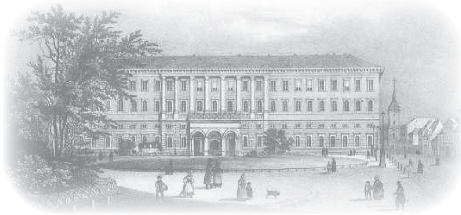
Das Postgebäude in Leipzig
